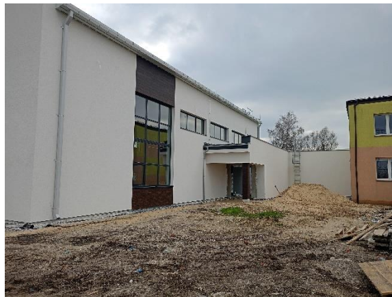
Zdjęcie 4 budowa Sali Gimnastycznej Rasy
