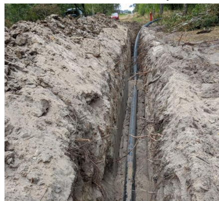
Zdjęcie 2 budowa sieci wodociągowej
