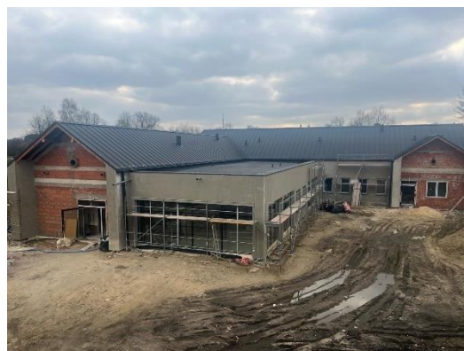
Zdjęcie 7 Budowa Centrum Kultury i Usług Społecznych w Drużbicach
