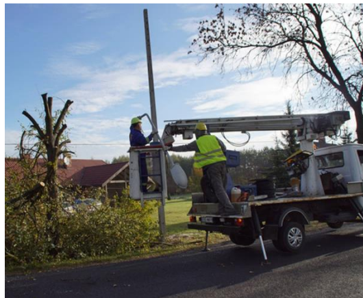
Zdjęcie 6 rozbudowa oświetlenia na terenie Gminy Drużbice
